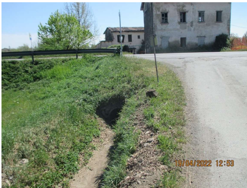
Figura 3.1 Vista da monte verso valle del manufatto di attraversamento da parte del Fosso 4.1.00 di Via Statale
