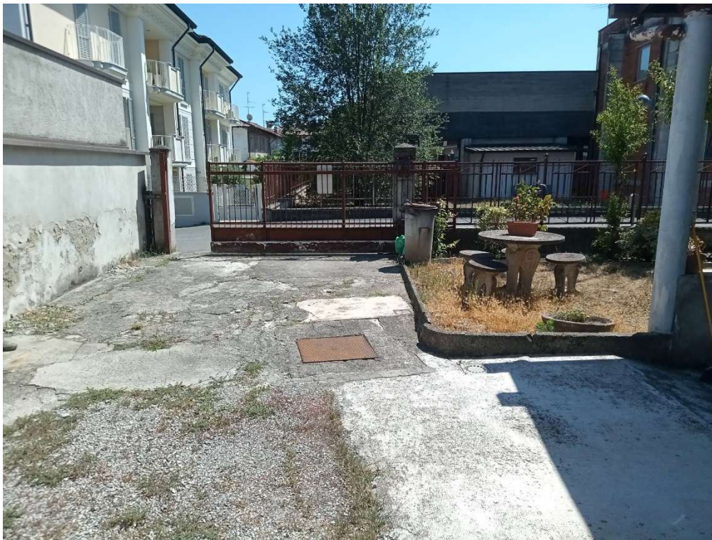
Figura 3.3 Vista da monte verso valle del punto di immissione del Fosso 3.2.00 in rete fognaria: il fosso corre intubato sotto il chiusino al centro della fotografia.
